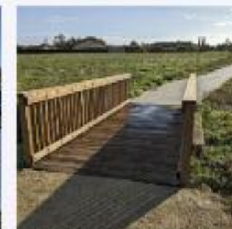
Pose d'une passerelle sur la voie verte reliant Vendeuve-du-Poitou à Chéneché
