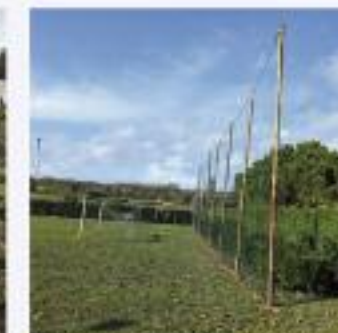
Reprise de la clôture du stade de Chéneché et pose d'un filet pare-balls
