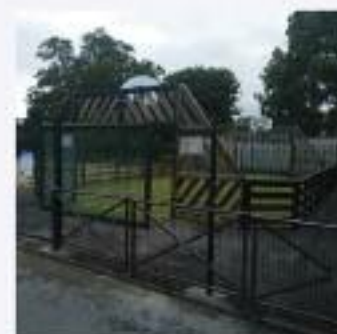
Clôture du City Stade de Vendeuve-du-Poitou
