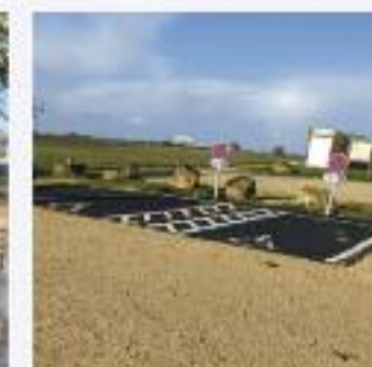
Mise en accessibilité des espaces publics création de places de stationnement PMR aux Tours Mirandes et sur le parking du cimetière de Blaslay
