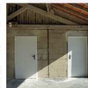
Achèvement des toilettes publiques de Varennes
